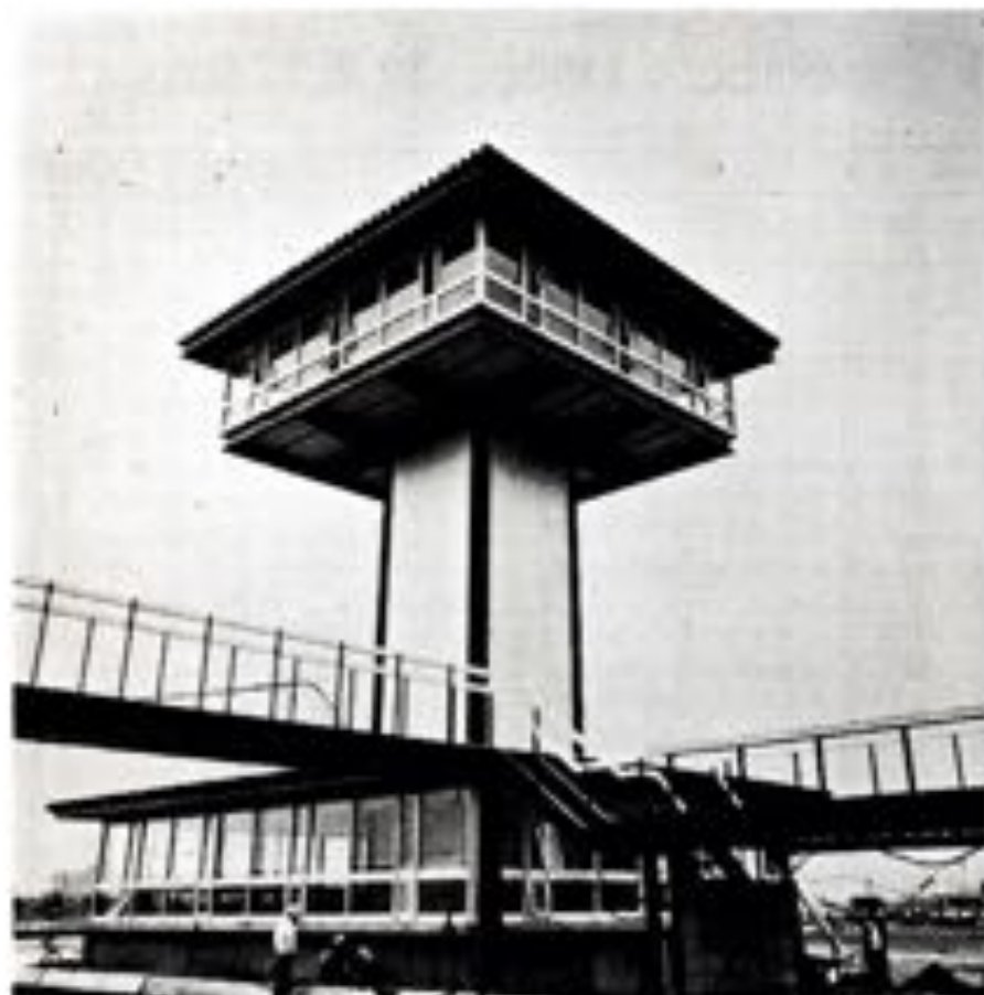
船橋サーキット・コース監視塔
